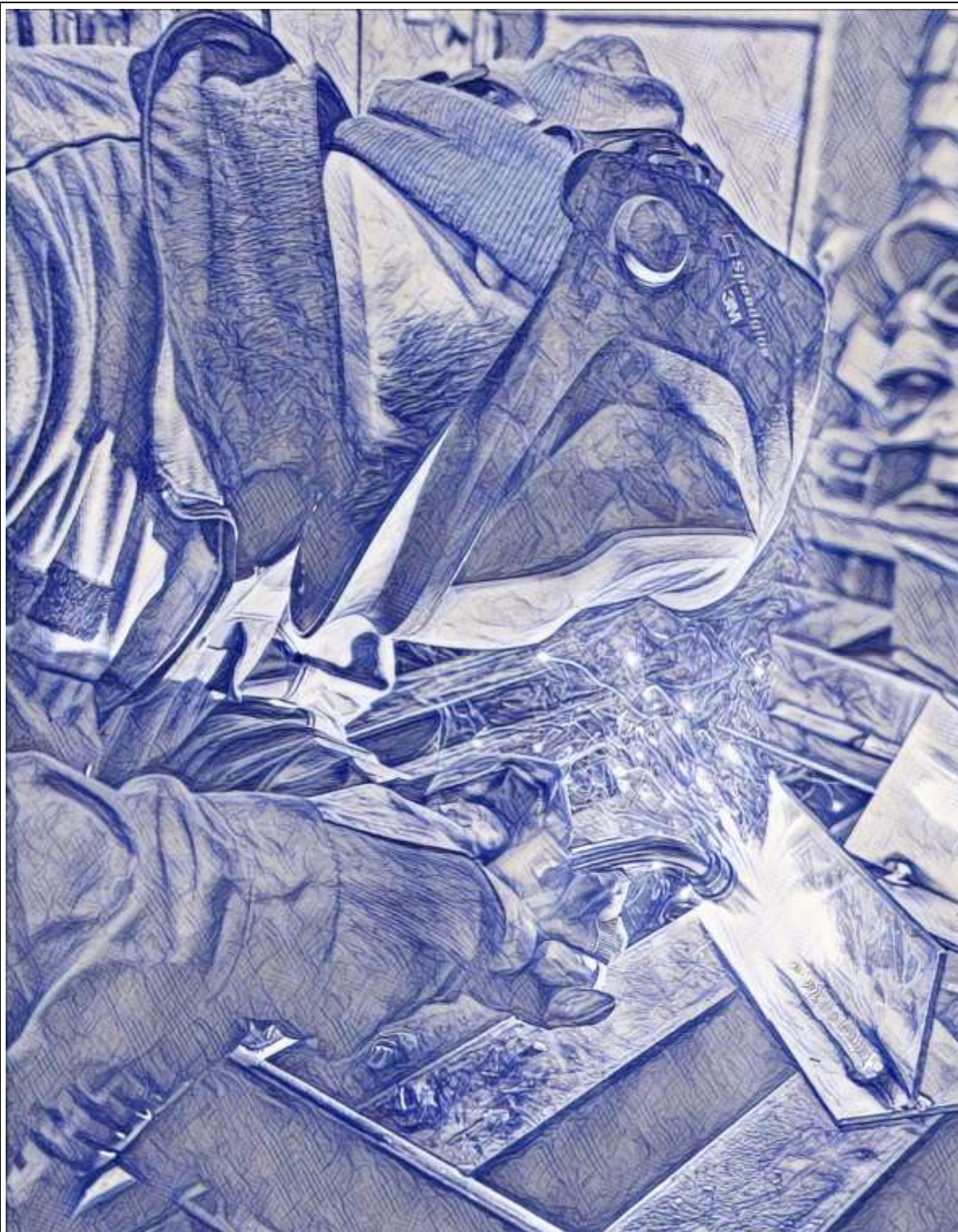
1.1. zīmējums. Pusautomātiskā metināšana aizsarggāzes vidē.
