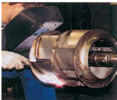
Сварка пропеллера вентилятора методом MAG
